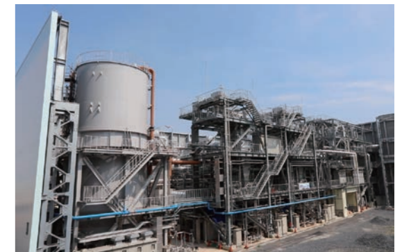
空見スラッジリサイクルセンター下水汚泥固形燃料化 事業（名古屋市上下水道局） DBO方式
