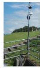
カメラによる監視
